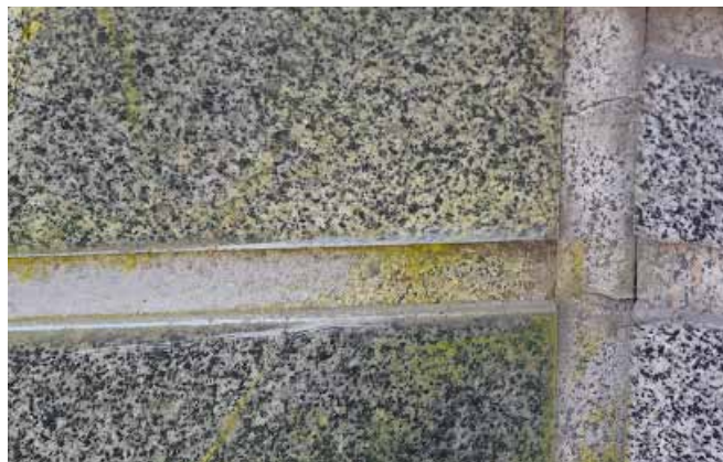
Рисунок 5. Варварське зафарбовування тегів чорною фарбою на поверхні лабрадоритового облицювання (Київ)
